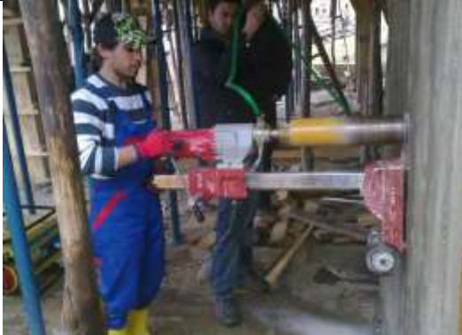
Karot Numune Alım Uygulaması
